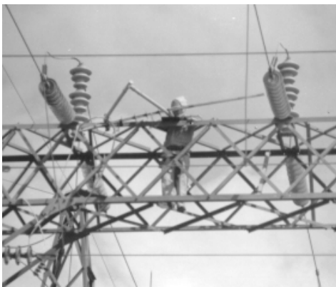
Fig. 1. Operador limpiando aisladores eléctricos
